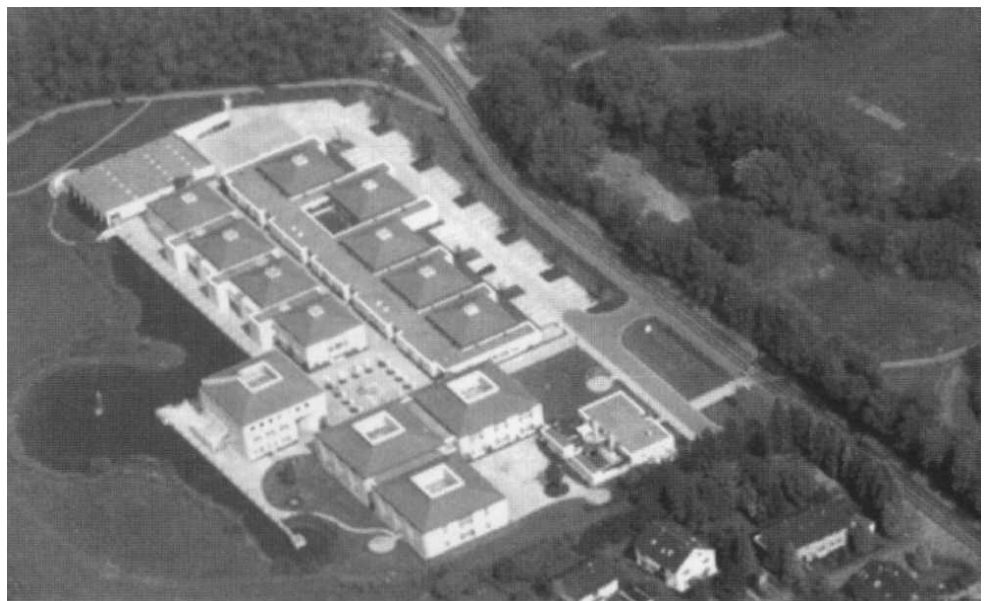
Neubau der Berufsschule und des Berufsbildungswerkes (Luftaufnahme)
